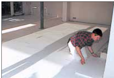
Verlegung der Wärme- und Trittschalldämmung auf ausreichend tragfähigem und ebenflächigem Untergrund
