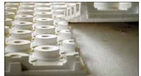
Auslegen und Zusammenfügen der Estrich-Noppenplatte Schlüter-BEKOTEC-EN/P (-EN/PF)
