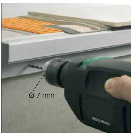
Nachträgliche Montage des Rinnensystems Schlüter®-BARIN an Randprofilen ohne Aufnahmeut
