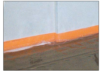
3 Einbau des Randstreifens BRS 810 oder BRSK 810 bei erdfuchtem Estrich. Bei Fließestrich sind die Randstreifen BRS 808 KF oder BRS 808 KSF mit Klebefuß zu verwenden.
