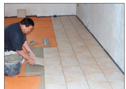
12 Verlegung des Fliesenbelags auf DITRA in Dünnbettmörtel.
